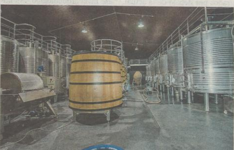
Depósitos. Tanques de acero, tinos de madera y una tinaja de barro (al fondo) en el interior de la bodega Regina Viarum. CARLOS RUEDA
